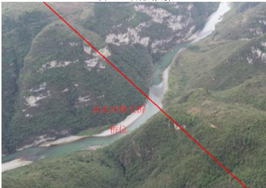
图 1.7-5 赤水河特大桥
